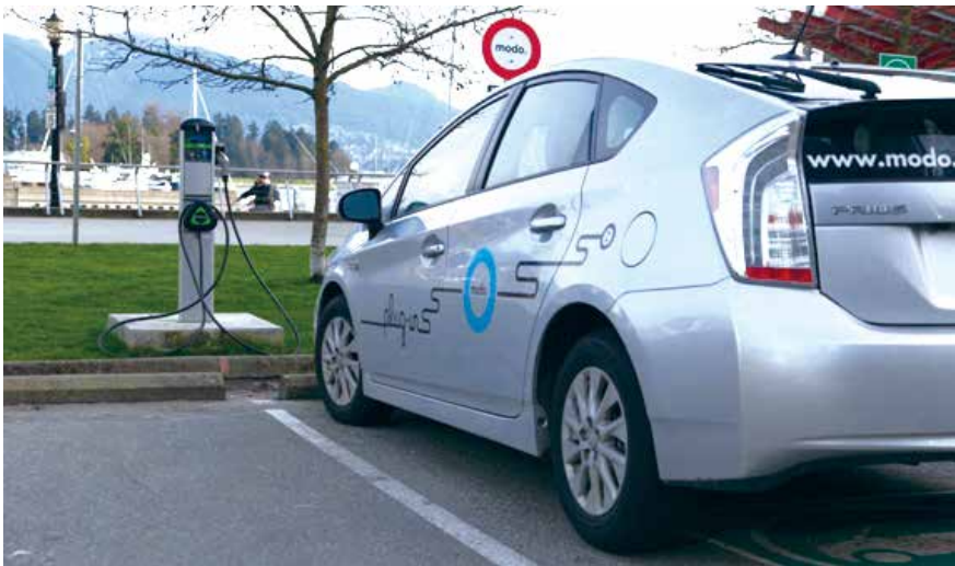
| 电动车充电站
