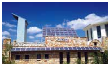
太阳能供电设备
